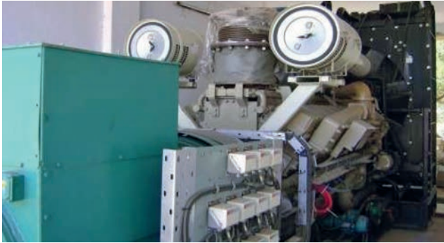
1 MW DA Cummins KTA50D M(1)
